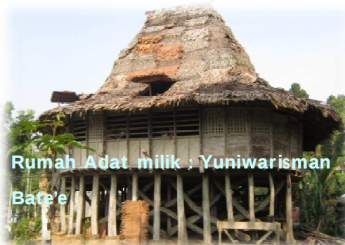
Rumah Adat Yang Masih Dalam Proses Pengerjaan
